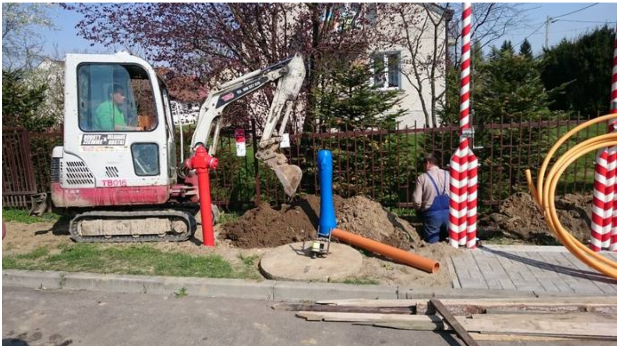
Przebudowa przyłącza gazu według obowiązujących przepisów. Fot. Piotr Mika.
