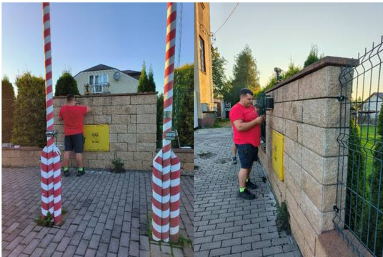
Prace modernizacyjne – montaż lamp. Fot. Weronika Mrozek.
